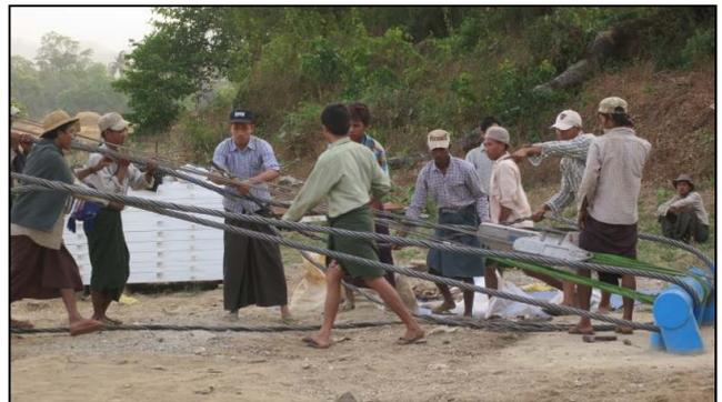
Et maintenant, de sept heures à neuf heures du soir, nous coupons les câbles pour les haubans, à côté de la rivière.
