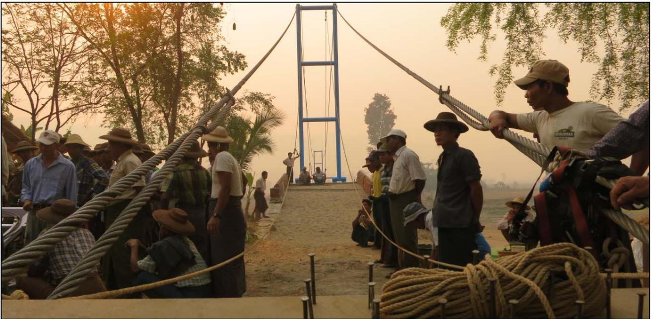
Depuis là, nous nous déplaçons le long des câbles jusqu'à l'autre pilier. Pendant le trajet nous fixons chaque câble des haubans à son emplacement déterminé. Les hommes dessous apportent le hauban suivant avec le cadre du plancher du pont et la plaque métallique qui va avec. D'autres encore serrent les boulons. Toutes
